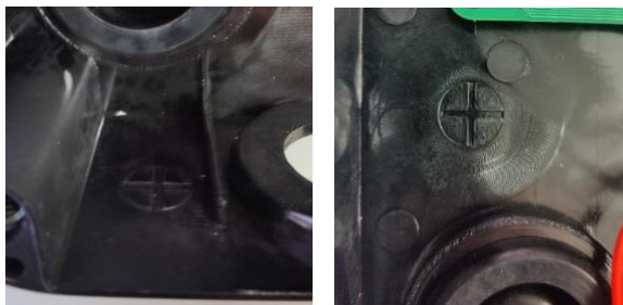
Figura 2 – Aree contrassegnate per l'installazione di ghierette aggiuntive
